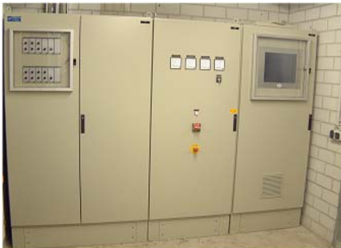
Ansicht Fertigstellung ISP01 EIB/KNX aussen
